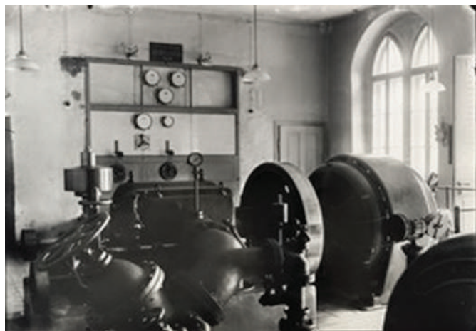
Сл. 129. Ентеријер хидроелектране „Вучје“ и Сл. 130. Генератор хидроелектране „Вучје“
