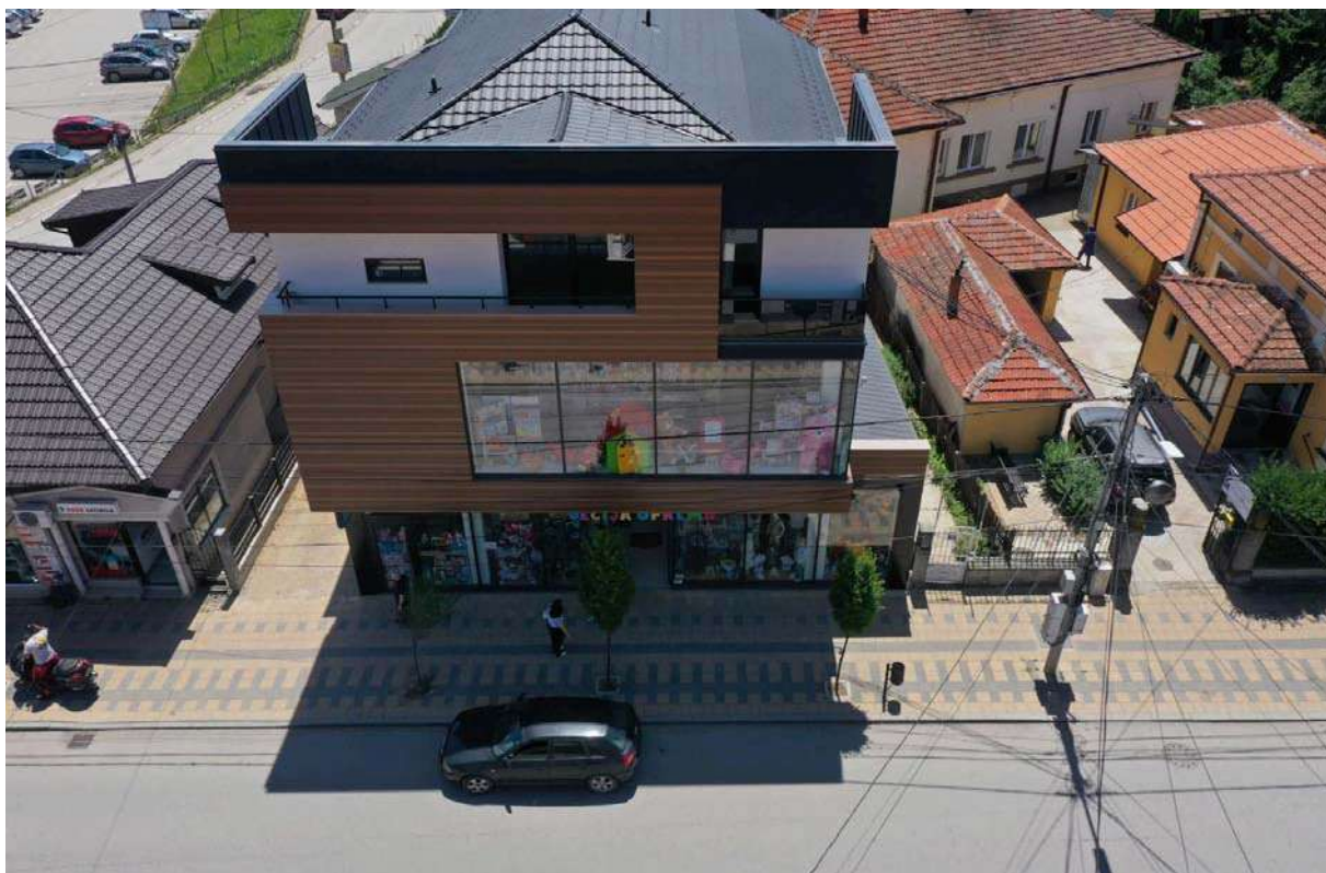
Непримерена градња, на простору улице Боре Станковића (Фото: ЗЗСК Ниш, А. Никшић, 2024)
