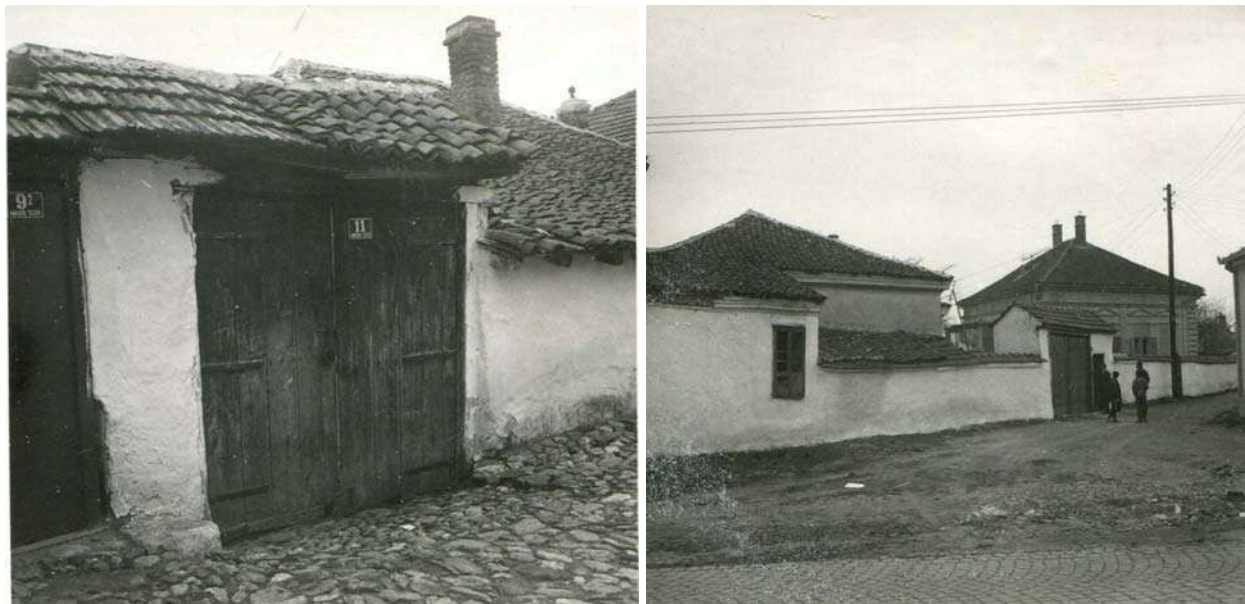
Капије и оградни зидови у Николе Тесле бр. 11 и Дунавској бр. 1 (фото: ЗЗСК Ниш, Ј. Шурдиловић, 1980)
