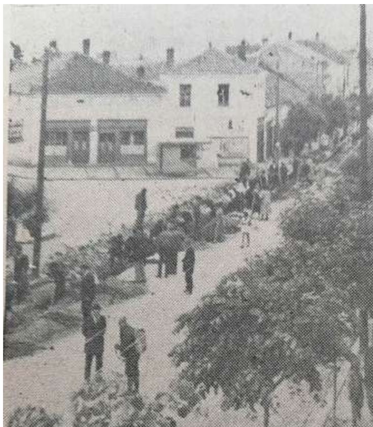
Изградња водовода у Врању (извор: Слободна реч, Врање)
