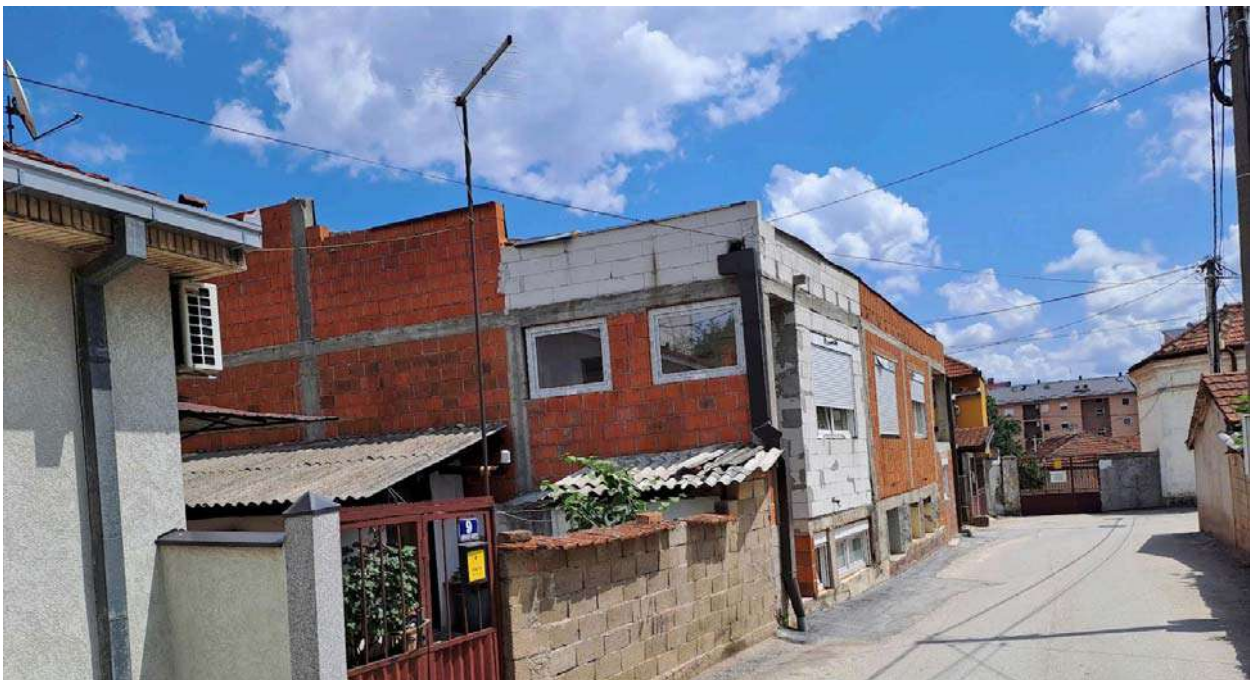
Објект у улици Албанске голготе бр.11 (фото: ЗЗСК Ниш, Ј. Шурдиловић, 1980, googlemaps, снимљено 2014 и И.Цветковић, 2024)
