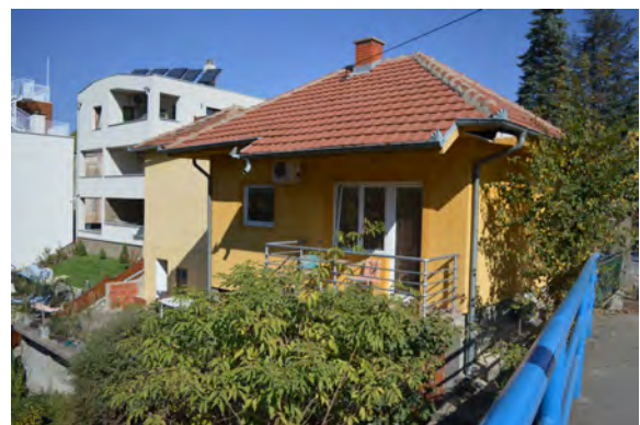
Изглед грађевина на раскрсници Улица војводе Мишића и врелске
