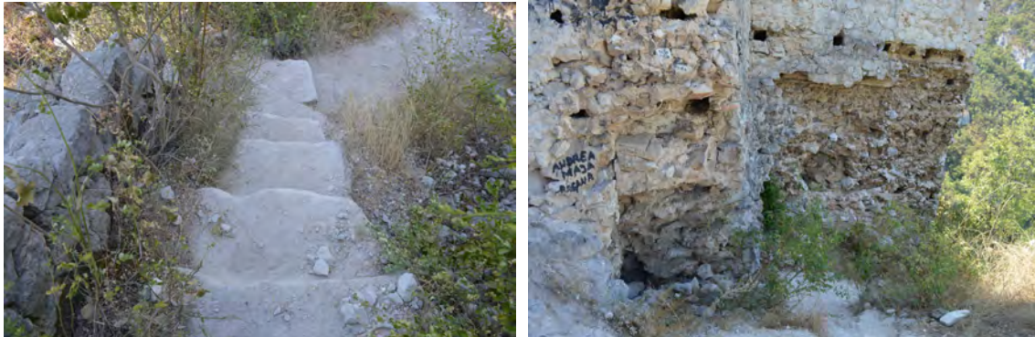
Деградација архитектонских структура Сокограда услед утицаја вегетације, небриге и вандализма, фотографија: Ивана Цветковић, 2017
