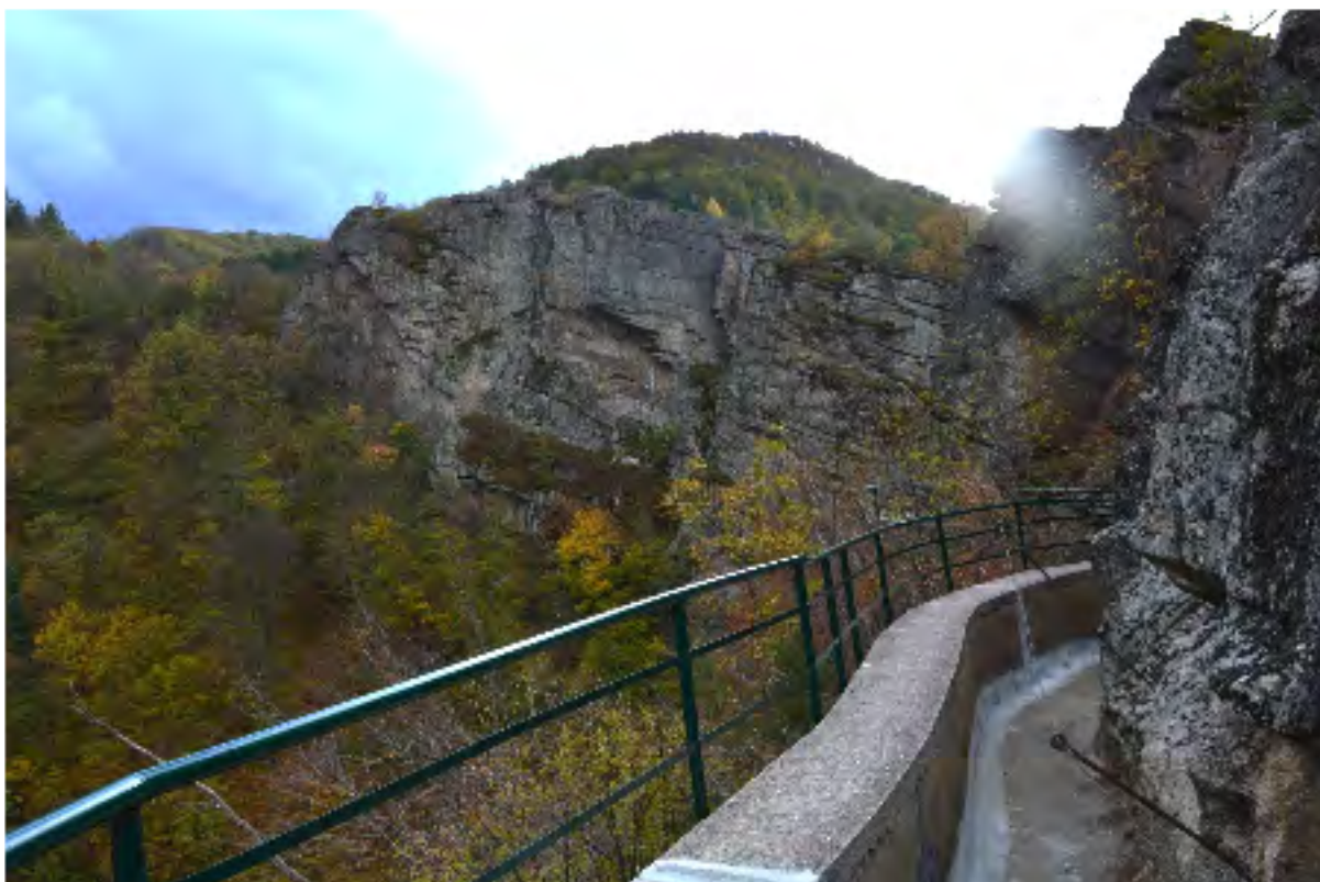
Канал за довод воде, фотографија ЗЗСК Ниш, Ивана Цветковић
