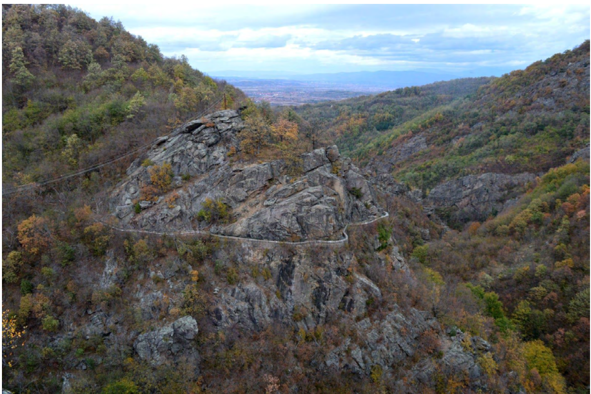
Поглед са видиковца Соколица на канал хидроцентрале, фотографија ЗЗСК Ниш, Ивана Цветковић, 2019.
