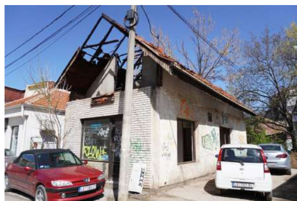
Објект на адреси Масариков трг бр. 26 (фото: И. Цветковић, 2024.)
