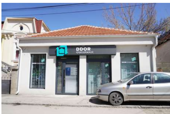
Објект на адреси Масариков трг бр. 30 (фото: И. Цветковић, 2024.)
