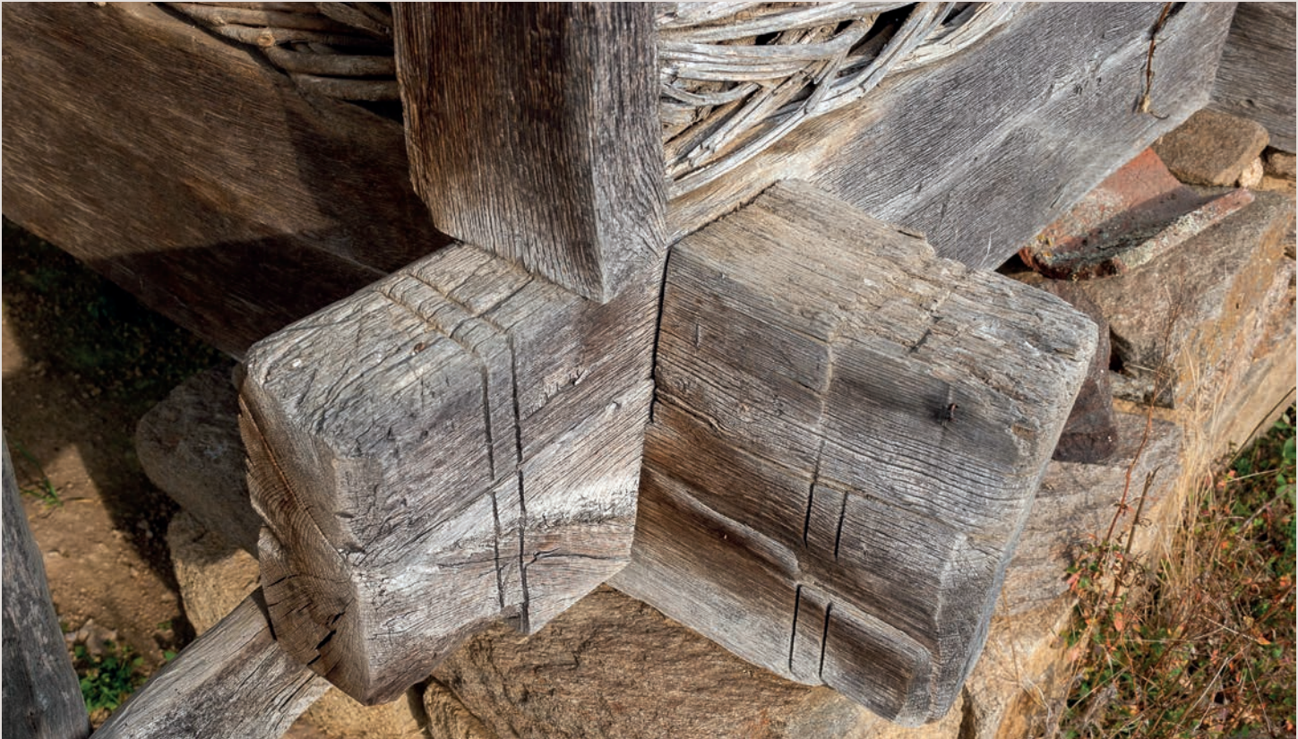
Сл. 202 Укрштене и усечене греде темељаче, на кошу Шабана Рамаданија, Муховац Figure 202 Intersecting Foundation Beams of Saban Ramadani's Corncrib, Muhovac
