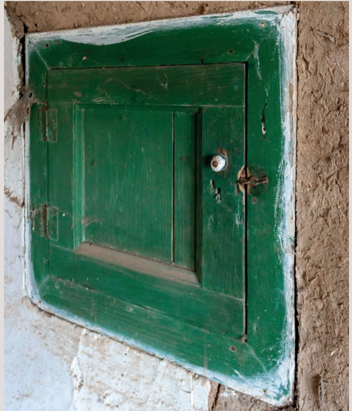
Сл. 190 Долап у кући Зијадина Арифџија, Буковац Figure 190 A Built-In Cabinet (dolap) in Zijadin Arifi's House, Bukovac
