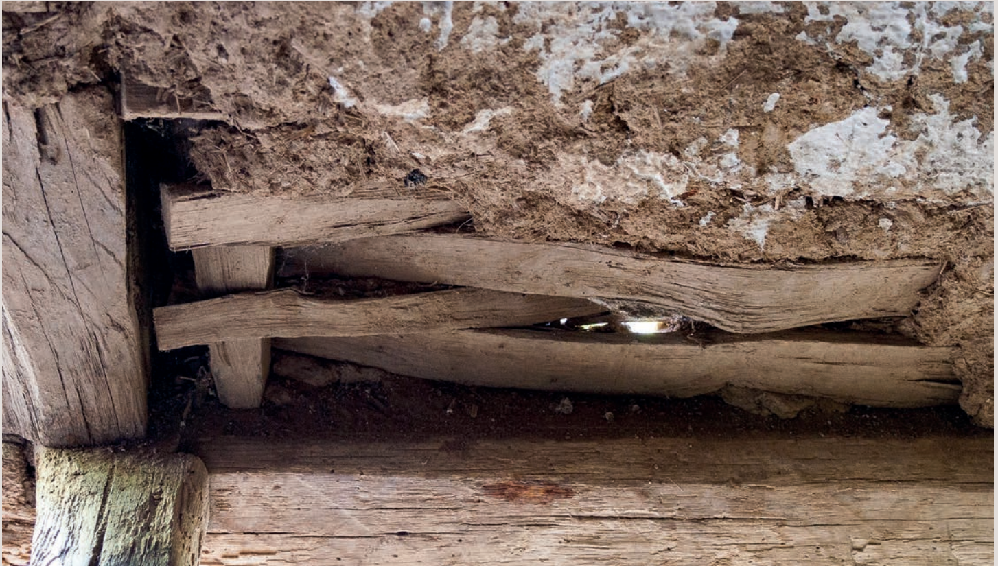
Сл. 179 Детаљ зидова од плетера на кући Зијадина Арифџија, Буковац Figure 179 A Detail on the Wattle Walls of Zijadin Arifi's House, Bukovac
