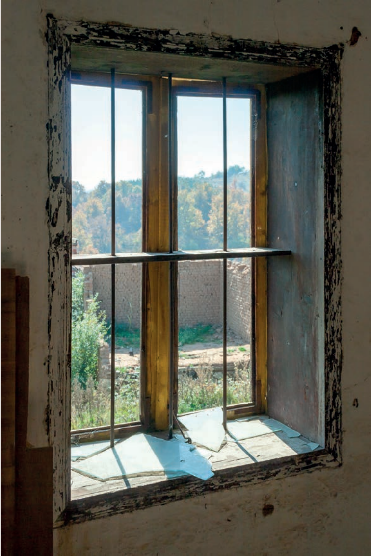
Сл. 163 Прозор са металном решетком на кући Николе Стефановића, Грамађа Figure 163 A Window with a Metal Grate on Nikola Stefanovic's House, Gramadja
