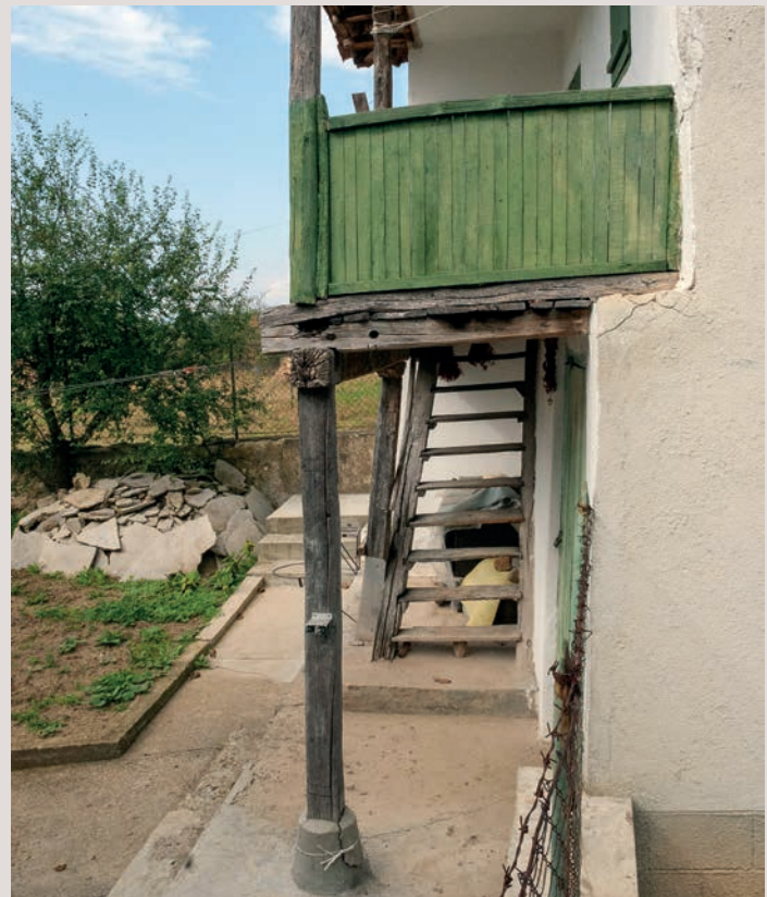
Сл. 152 Детаљ куће - одаје Миладина Стојановића, Кршевица Figure 152 A Detail on Miladin Stojanovic's House - Chamber, Krsevica
