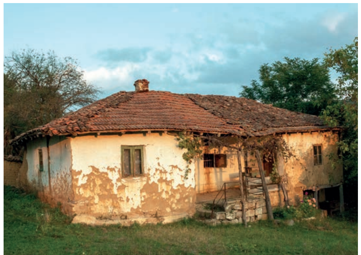
Сл. 26 Кућа Станоја Павловића, Клиновац Figure 26 Stanoje Pavlovic's House, Klinovac
