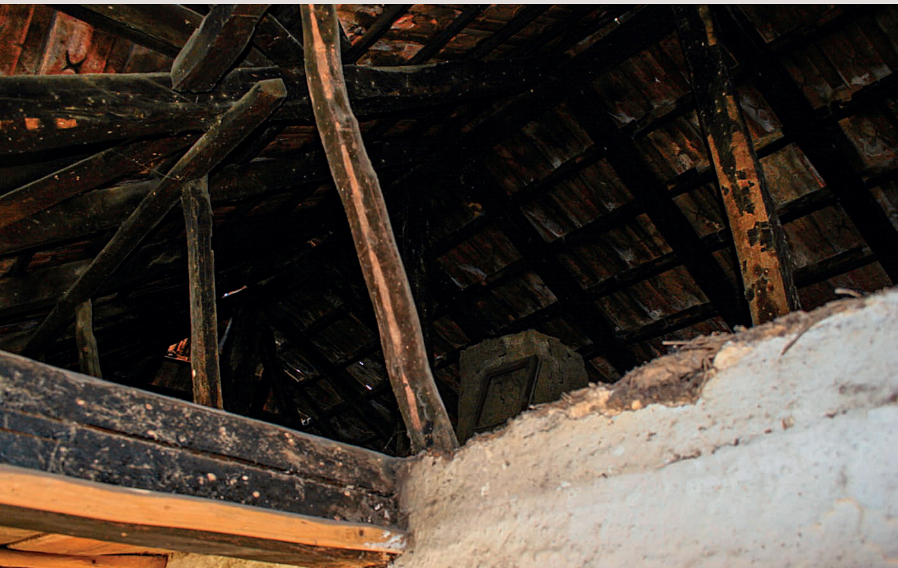
Сл. 165 Кровна конструкција куће Николе Стефановића, Грамађа Figure 165 The Roof Construction of Nikola Stefanovic's House, Gramadja
