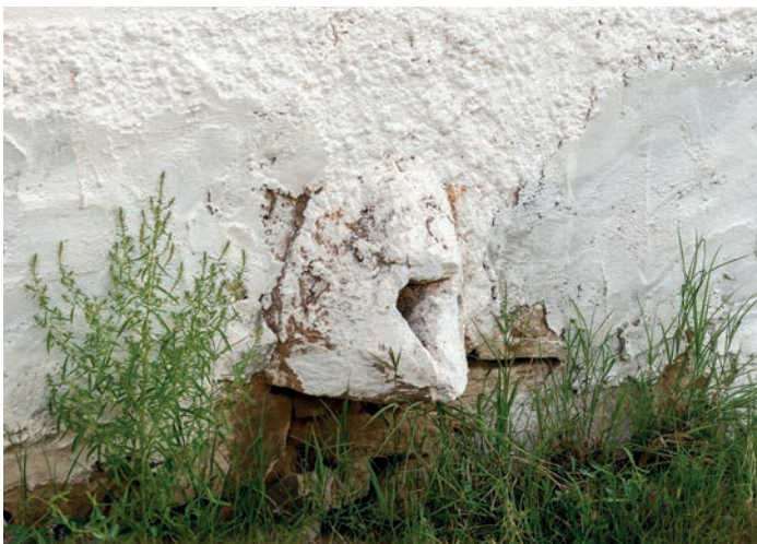
Сл. 73 Детаљ куће Фатмира Јашарија, Алиђерце Figure 73 A Detail in Fatmir Asari's House, Alidjerce
