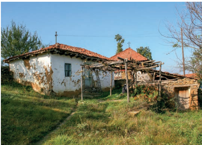
Сл. 19 Кућа Загорке Станковић, Барањевац Figure 19 Zagorka Stankovic's House, Baraljevac
