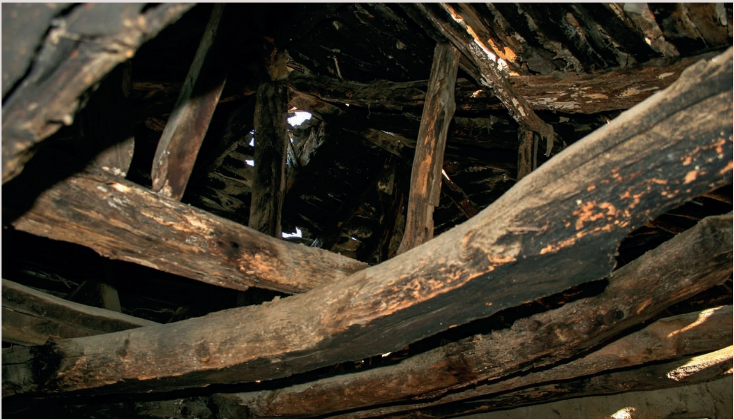
Сл. 212 Кровна конструкција казанце, махала Сенкарци, Сејаце Figure 212 Roof Construction of the Tank Room in Senkarci Mahalla, Sejace
