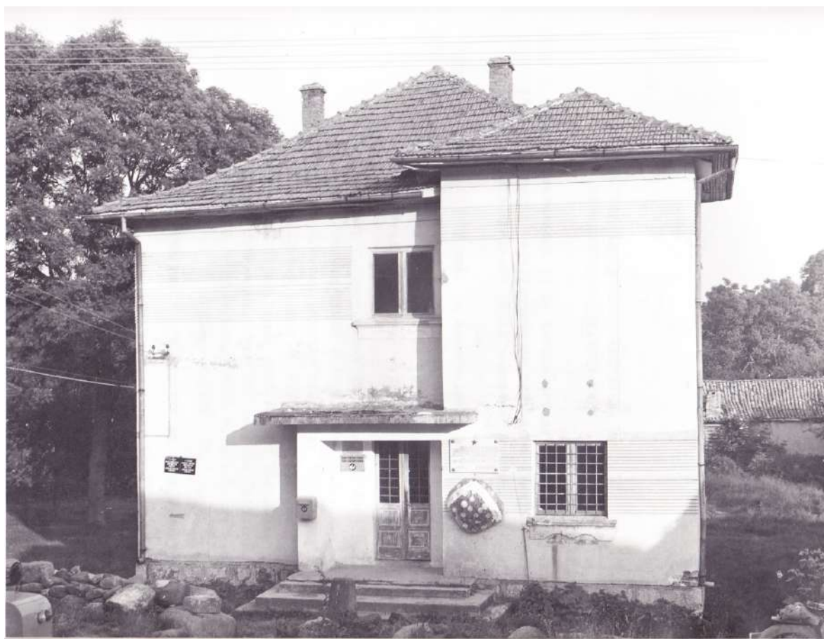
Спомен плоча на фасади зграде месне канцеларије у Каменици, изглед 1980. године (фотографија: ЗЗСК Ниш, 1980.)
